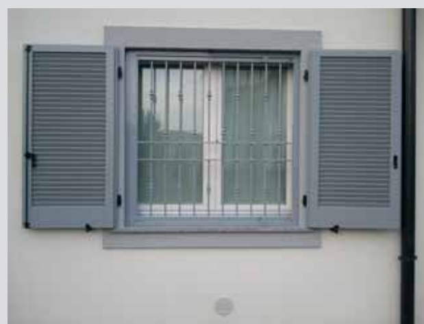
serramenti in legno con persiane e inferriate di sicurezza con snodo per ribaltamento a 180°
