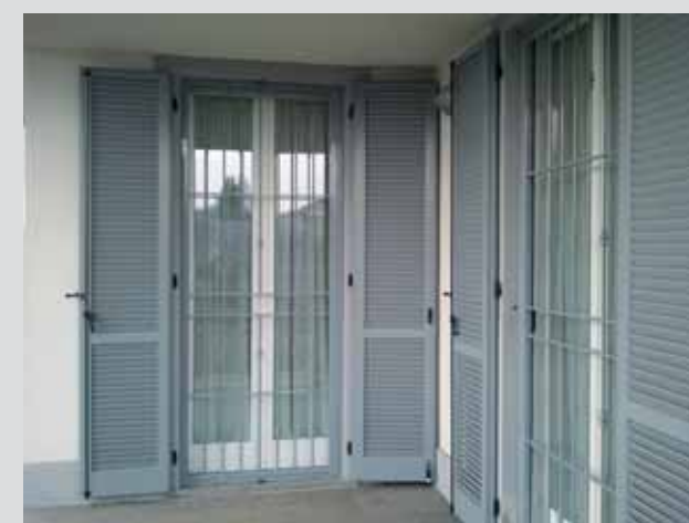
serramenti in legno con persiane e inferriate di sicurezza con snodo per ribaltamento a 180°
